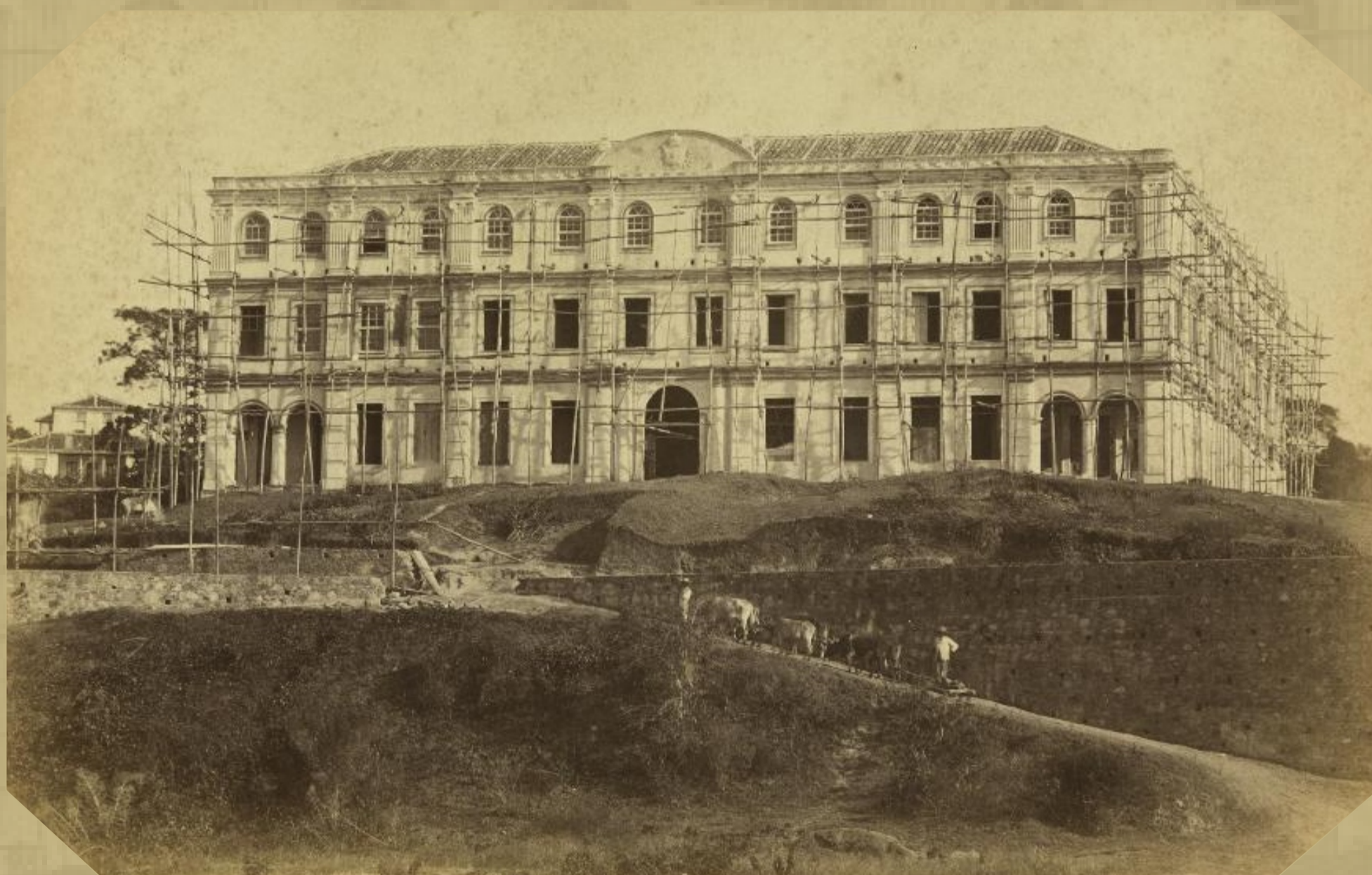
Final da construção da Escola Agrícola da Bahia. São Bento das Lages (São Francisco do Conde, Bahia), 1872. Fonte: Brasileira fotográfica, Fundação Biblioteca Nacional.
